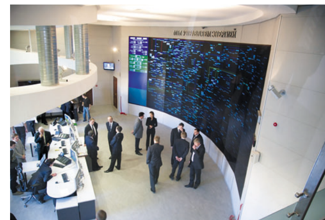
Центральный диспетчерский пункт РДУ ОАО «Башкирэнерго»
